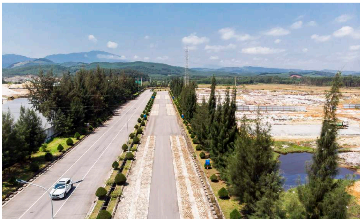
Độ dài 50m cho mỗi dạng đường sỏi, gồ ghề, và đường lượn sóng. 50 meters are dedicated for each track of slippery gravel road, uneven road and wavy road.
