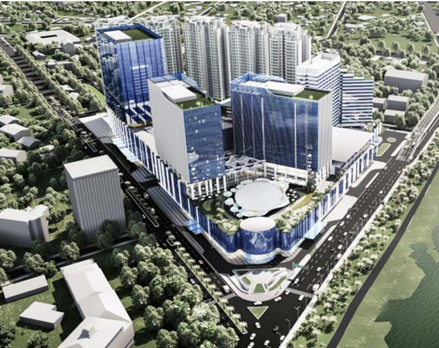
Yangon Myanmar Centre đã bước vào giai đoạn 2, tiếp tục xây dựng và hoàn thiện các hạng mục trung tâm thương mại, căn hộ và văn phòng.
